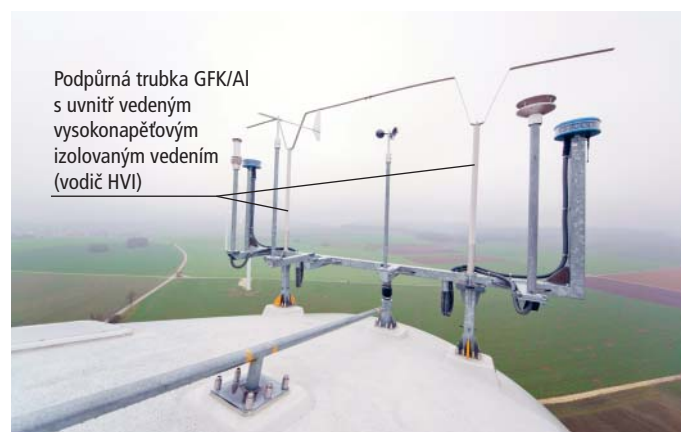
Obrazek 9.16.2 Příklad jímací soustavy pro meteorologickou stanici a pro výstražné letecké osvětlení
