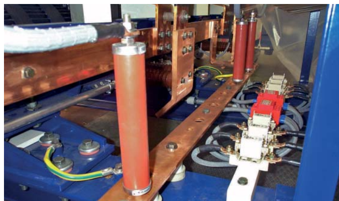
Obrázek 9.16.9 Svodič pro vn DEHNmid instalovaný na transformátoru větrné elektrárny
