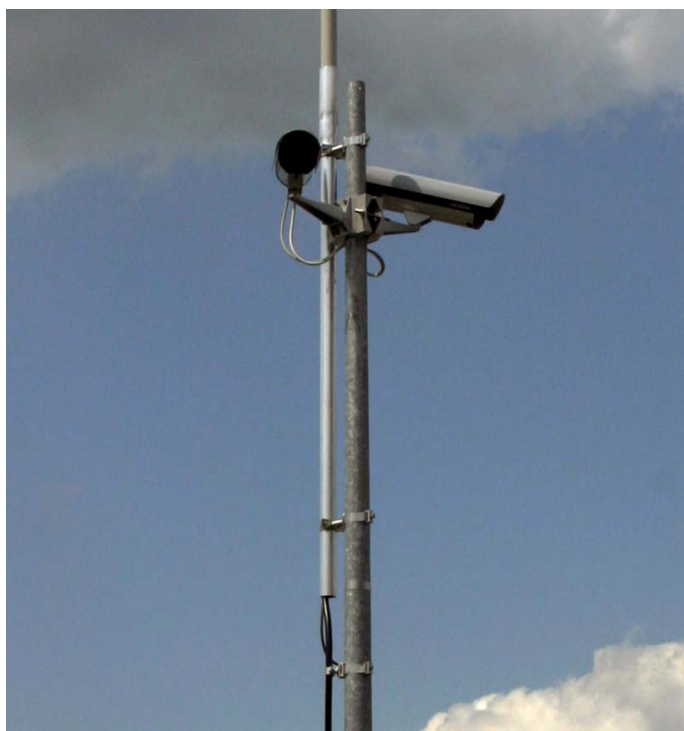
Obrázek 9.22.4 Vodič HVI instalovaný na stožáru
