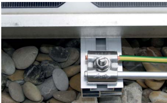
Obrázek 9.18.3 Zemní svorka UNI: mezičlen z korozivzdorné oceli zabráňuje kontaktní korozi. Tím jsou vytvořena dlouholetá spolehlivá propojení mezi různými materiály vodičů.
