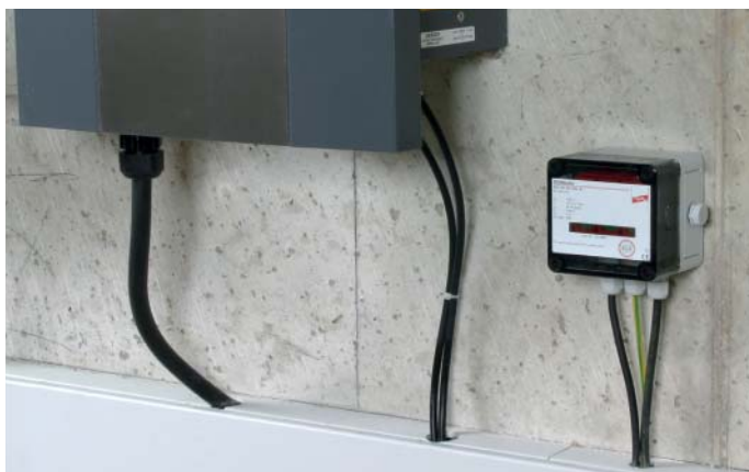
Obrázek 9.18.16 Svodič typu 2 DEHNcube YPV SCI 1000 1M pro ochranu měničů (1 MPPT)
