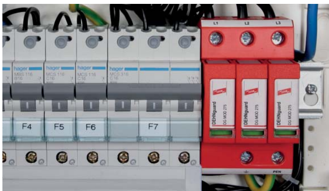
Obrázek 9.16.6 Modulární svodič přepětí SPD typu 2 pro ochranu sítě 230/400 V
