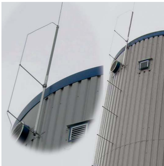
Obrázek 9.3.7 Ochrana kvasného tanku z kovových plátů pomocí oddáleného jímáče (zdroj: Büro für Technik, Hösbach)
