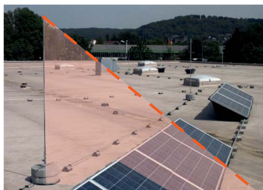
Obrázek 9.18.14 Stanovení ochranného prostoru metodou ochranného úhlu
