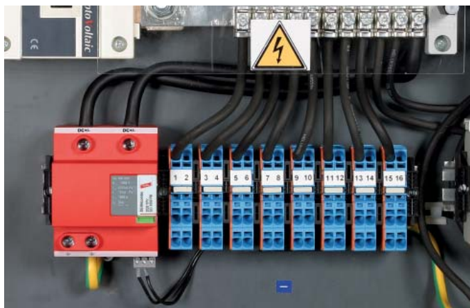
Obrázek 9.19.11 Přepětová ochrana v rozvaděči přípojení FV generátoru s monitoringem stringů
