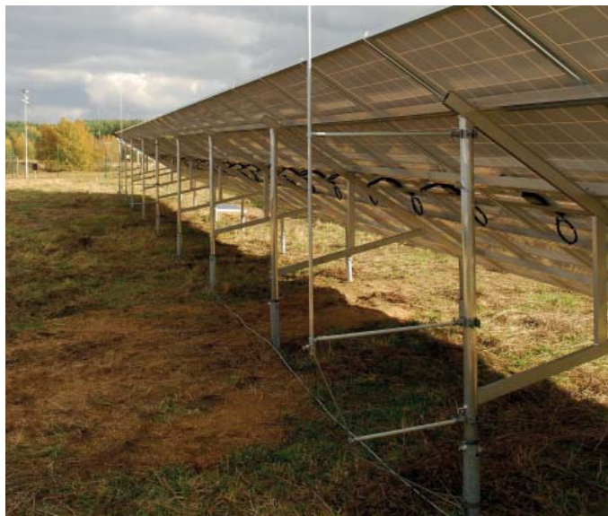
Obrázek 9.19.2 Hromosvod s držáky DEHNiso
