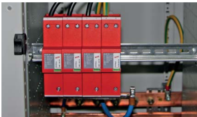
Obrázek 9.16.8 Koordinovaný svodič přepětí SPD typu 1
