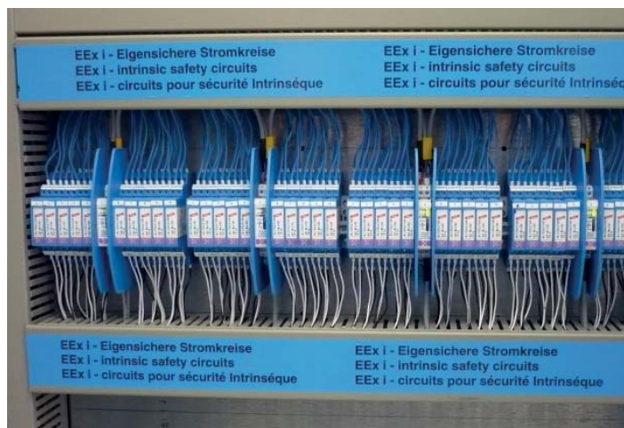
Obrázek 9.32.5 Přepětové ochrany pro jiskrově bezpečné měřicí obvody
